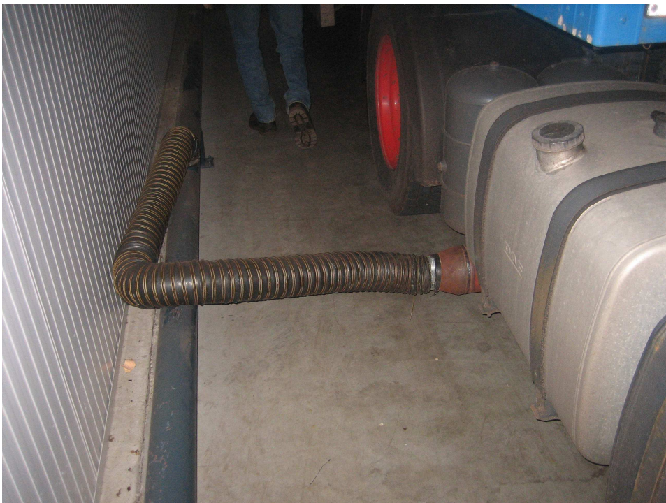
Figuur 8 De uitlaat van de vrachtwagen is aangesloten op het centrale afzuigstelsel
